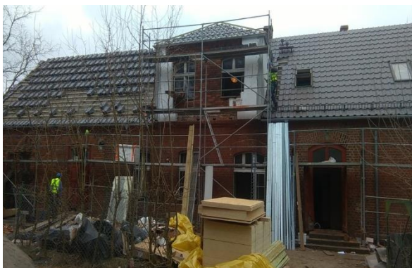
Fot. 2. Budynek w trakcie remontu.
