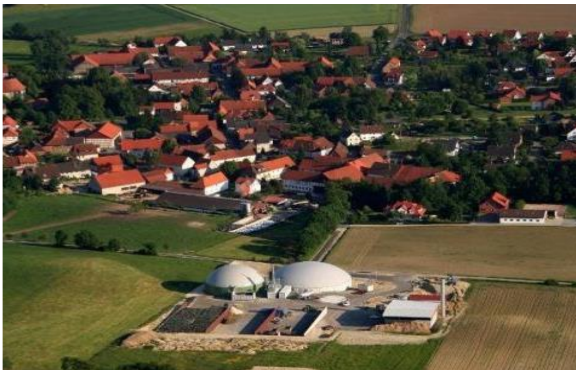
Fot. 21 Bioenergetyczna wieś Jühnde w Niemczech.
