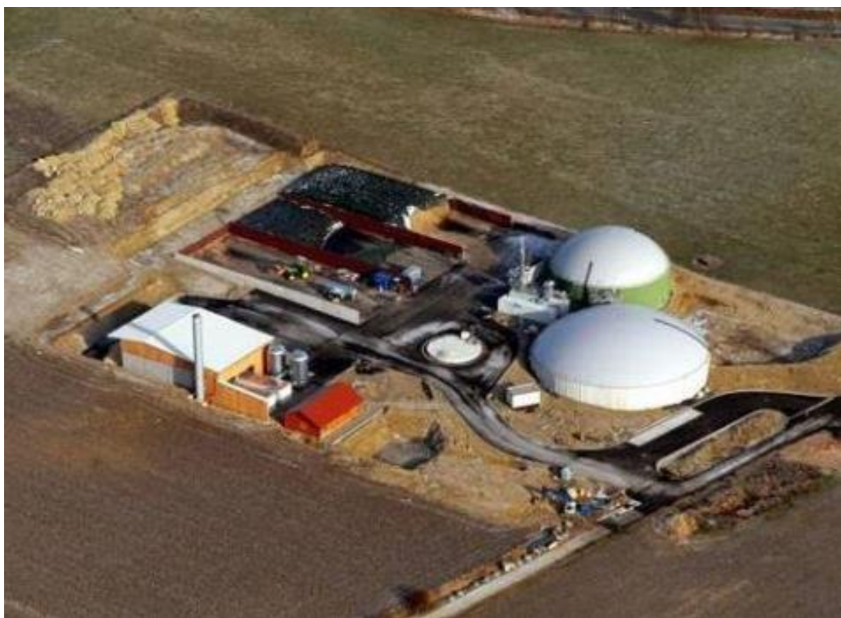
Fot. 20 Niekonwencjonalna elektrociepłownia w Jühnde.
