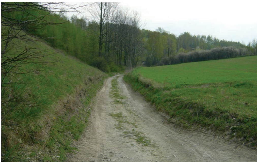
Obiekt Sławniów, przykład drogi gruntowej. Stan przed scaleniem
