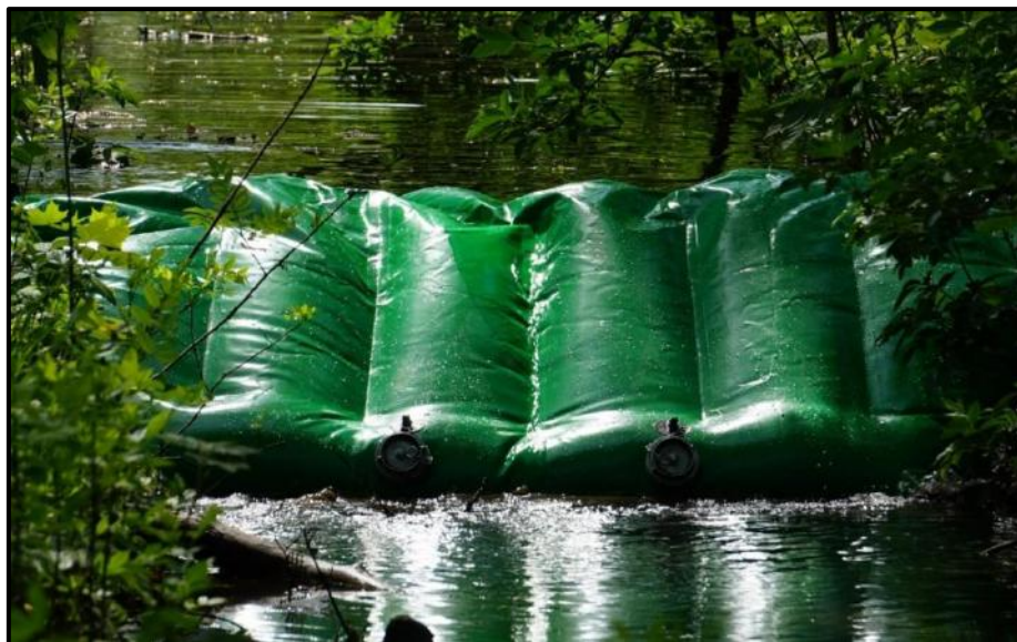
Fot. 8. Przenośny próg piętrzący (fot. K. Karpińska)
