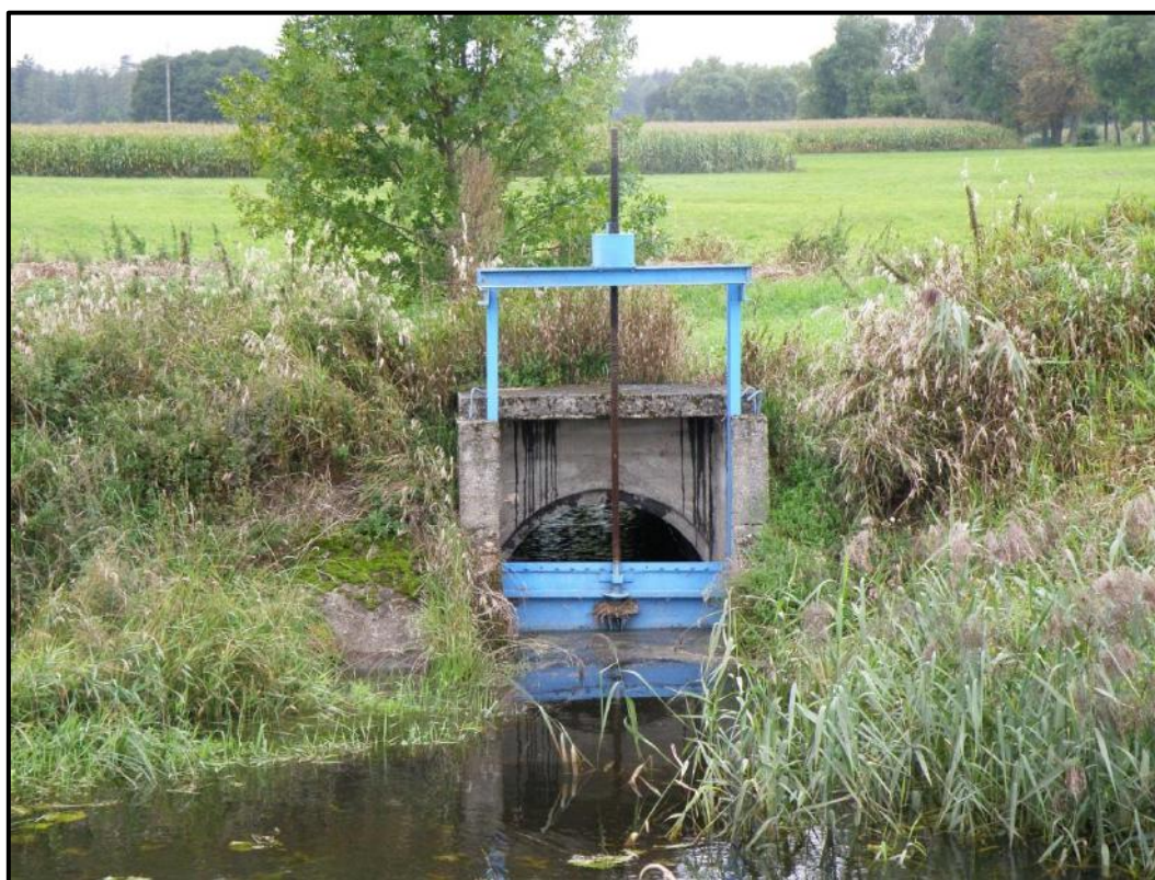
Fot. 2. Zastawka ze stalową zasuwą na doprowadzalniku (fot. Z. Kowalewski)
