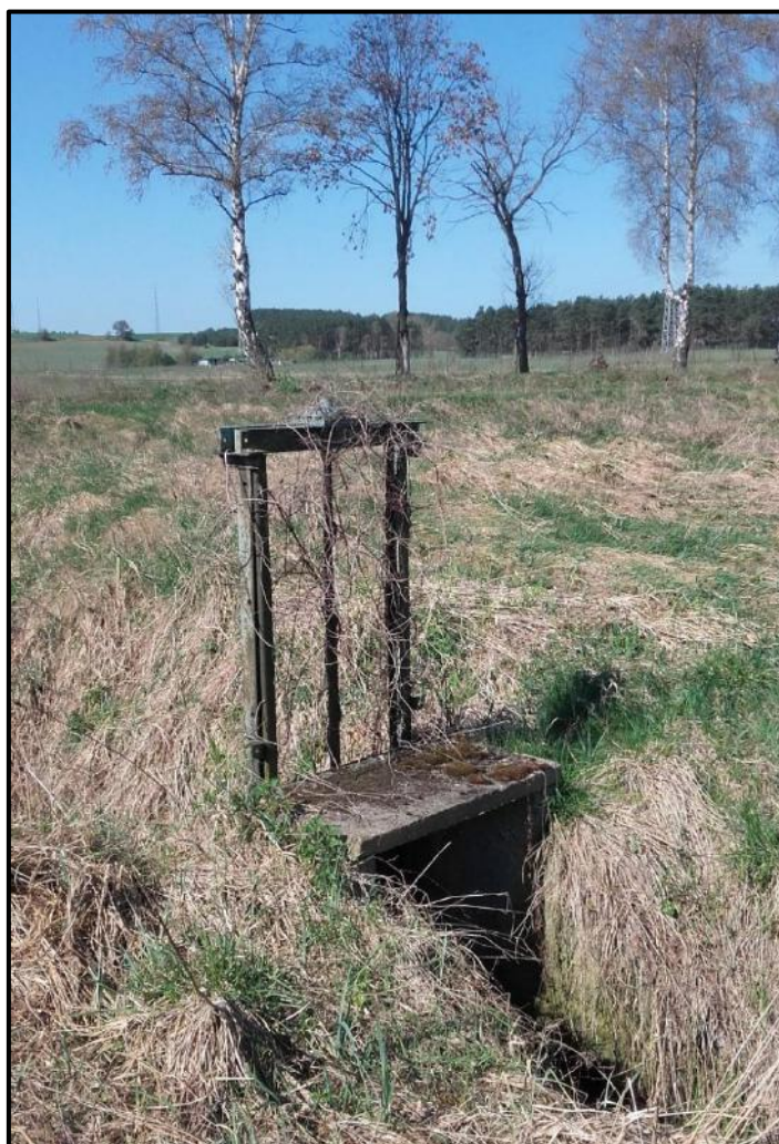
Fot. 3. Zastawka melioracyjna wśród nieużytków i na nieużytkowanym rowie (fot. B. Kierasinski)
