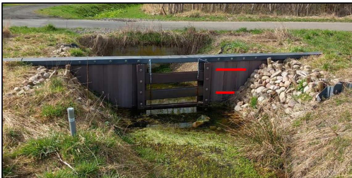
Fot. 5. Ażurowe zamknięcie szandorowe na zastawce ze ścianką szczelną z grodzie; (czerwone linie to repery wysokości piętrzenia wody - fot. B. Kierasinski)
