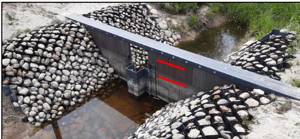
Fot. 6. Zamknięcie U-kształtne na ścianie szczelnej (czerwone linie jak na fot. 5) (fot. B. Kierasiński)
