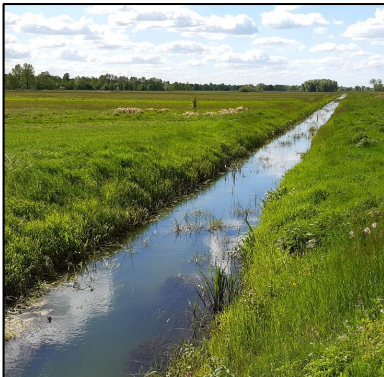
Fot. 12. Rów (kanał) nawadniająco-odwadniający na obiekcie melioracyjnym, bez możliwości piętrzenia wody (fot. B. Kierasiński)
