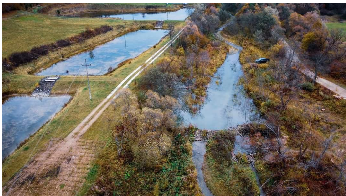
Fot. 8. Retencja sztuczna (po lewej) i retencja naturalna, wykonana przez bobry (po prawej) (fot. A. Czech)
