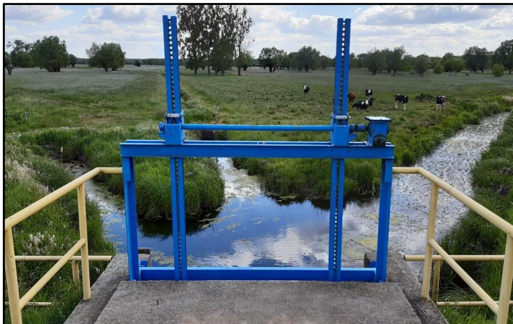
Fot. 1. System nawodnień podsiąkowych z budowlą piętrzącą wodę (fot. B. Kierasiński)
