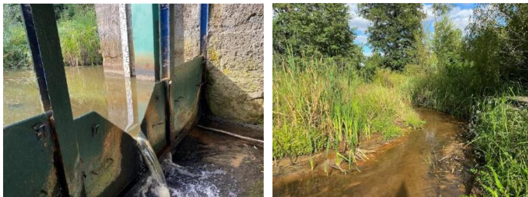
Fot. 2. Przelew pomiarowy w Czarnej-Młynie na Zagożdżonce i koryto rzeki poniżej przelewu i posterunku badawczego SGGW w Płachtach Starych na Zagożdżonce (18.08.2025) (fot. K. Banasik)
