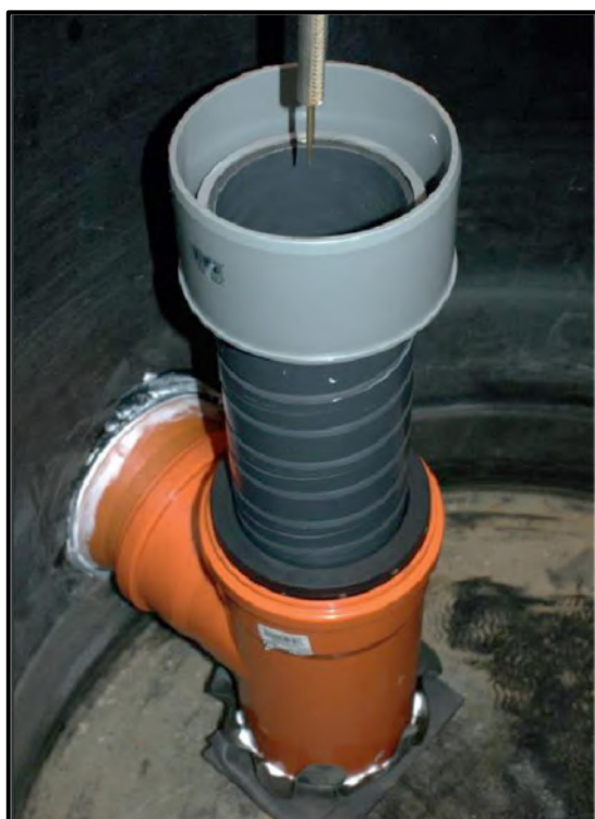
Fot. 9. Regulator kielichowy gwintowany, (źródło: SZYMCZAK, KIERASIŃSKI, KLASICKA, 2022)
