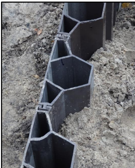
Fot. 4. Ścianka szczelna z grodzie (fot. T. Szymczak)
